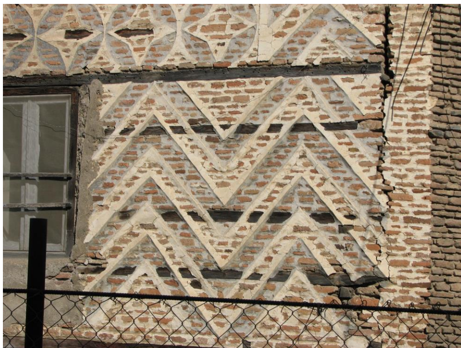
تزئینات موج و ستاره ای با کادر دایره ضلع جنوبی خانه درزی
