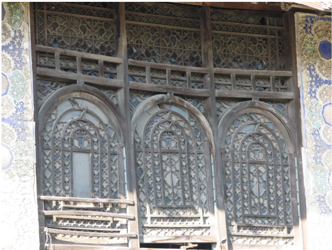
نمای از پنجره ارسی و تزئینات گچبری در دو طرف از بیرون
