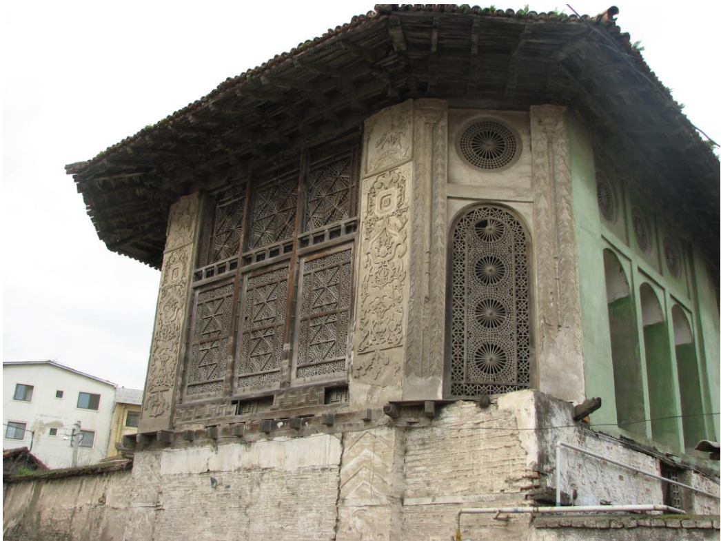
تزیینات گچبری و پنجره ارسی ضلع شرقی خانه شفاعی
