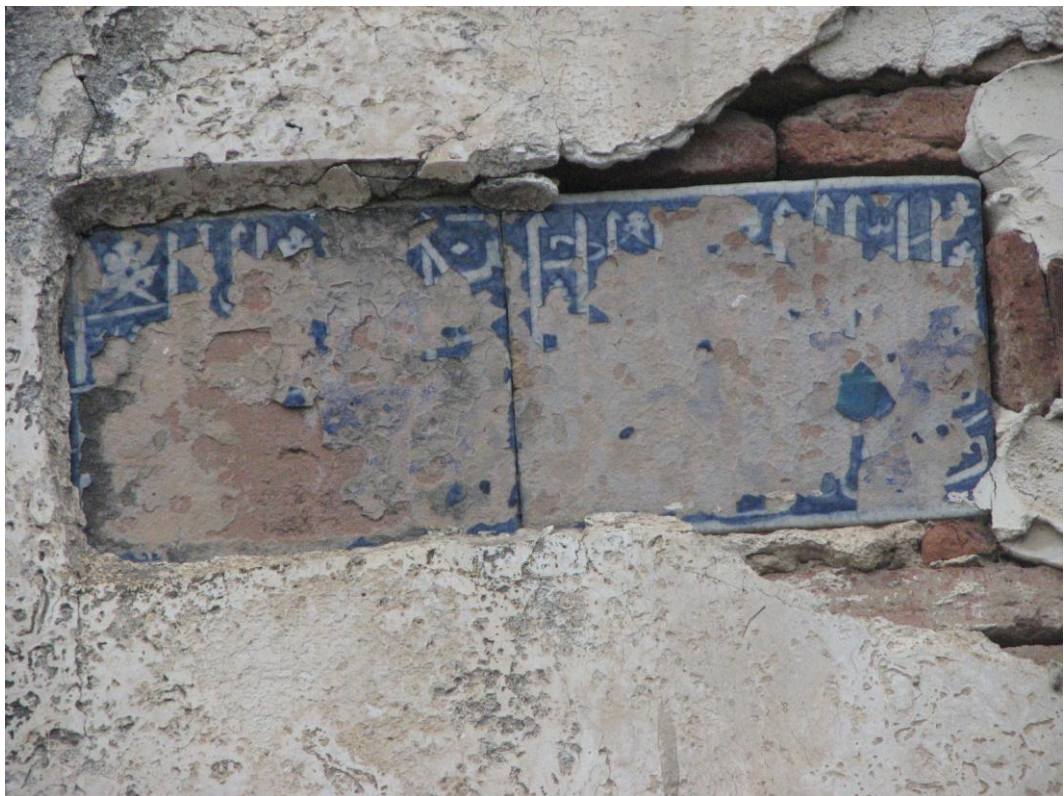
قطعاتی از کاشی کتیبه دار با لعاب آبی و حروف قرآنی ضلع جنوبی
