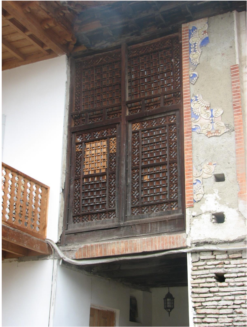
پنجره مشبک کاری شده کشویی نمای جنوبی خانه قاجاری منوچهری
