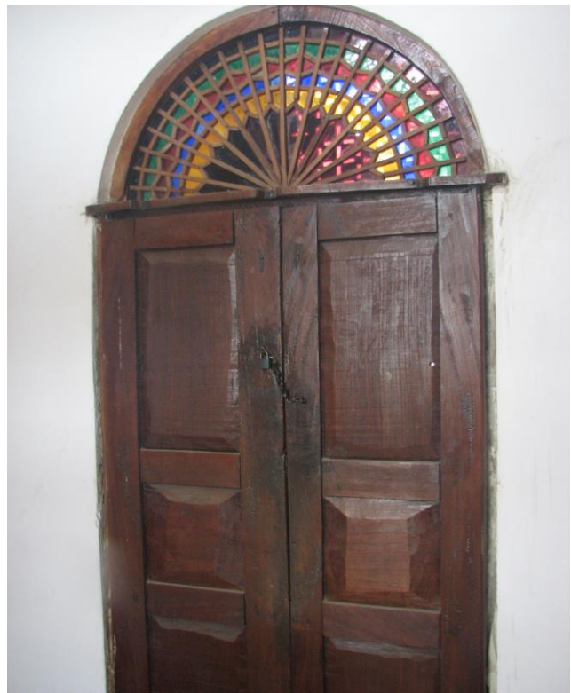
در دو لنگه ای با سر در چوبی مشبک کاری خانه منوچهری
