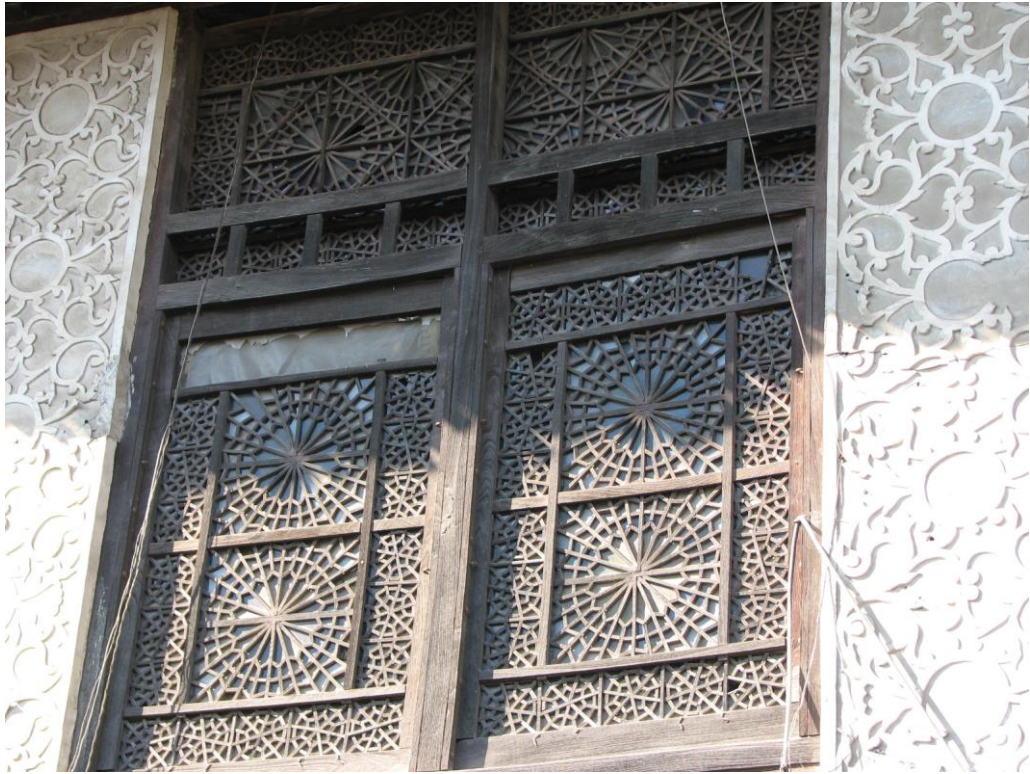
نمای از پنجره های دو لنگه ای کشوئی نمای شرق خانه درزی
