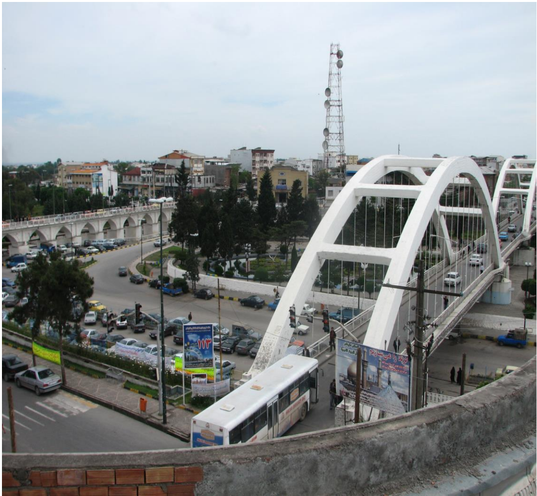
پل فلزی (( معلق)) آمل دید از غرب به شرق
