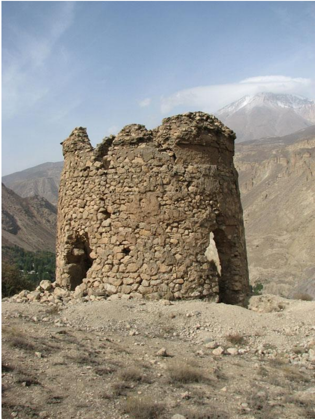
برج سی شاهاندشت دید از شمال شرقی به جنوب غربی
