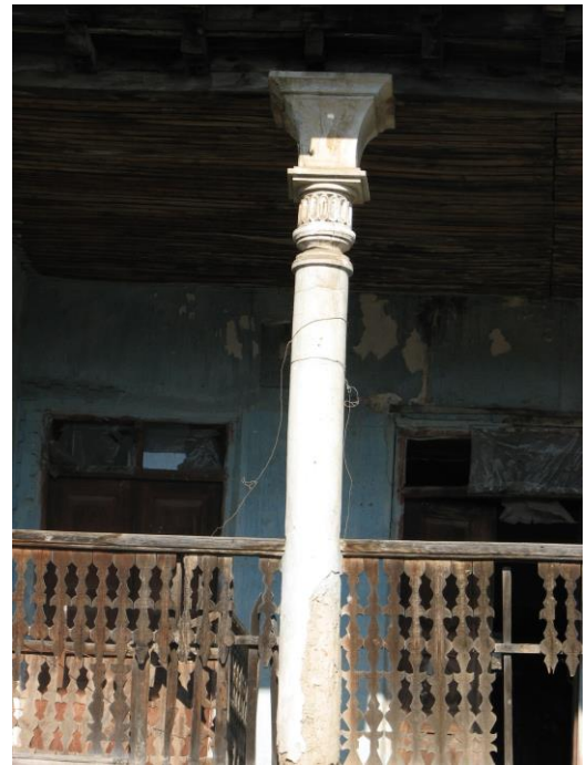
نمای از ستونهای خانه ملکی
