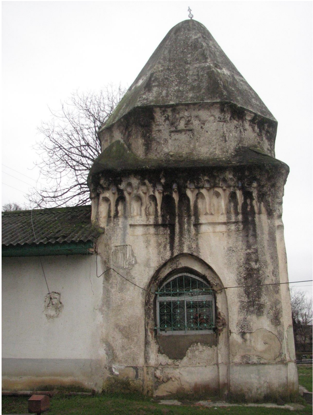
نمای از ضلع شمالی بقعه درویش اسماعیل
